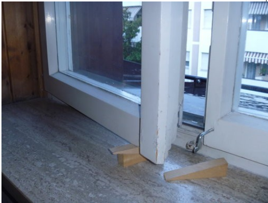
Fig. 21: Beispiel für einen Doppelkeil zum Fixieren des Fensters auf die gewünschte Spaltbreite
