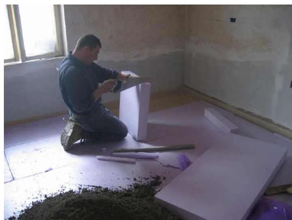
Darüber kommt noch der schwimmende Estrich mit Trittschall dämmenden Randstreifen und darauf dann der Bodenbelag (Holz, Fliesen):
