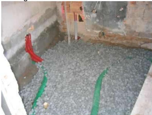
An der Innenseite der Außenmauer wird für die Verlegung der Heizungszuleitung eingeschlitzt, um den Fußpunkt der Mauer warm und damit trocken zu halten:
