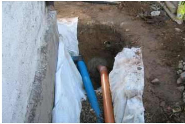
Auch innen wird ein Drainagerohr eingebracht, welches mit dem äußeren verbunden wird:
