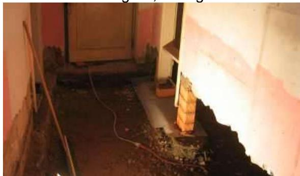
Aussen wurde bis auf Fundamentunterkante ein Graben gehoben, ein Drainagerohr eingebracht und das Regenwasser korrekt abgeleitet:
